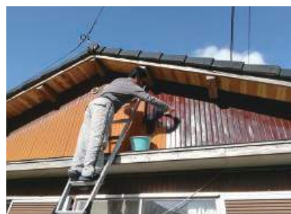
移住体験住宅改修の様子
